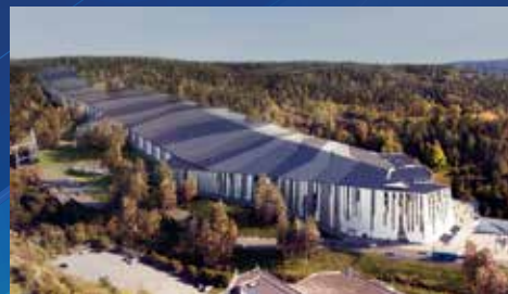
Energisentral og rørentreprise for kjøling og varmegjenvinning
