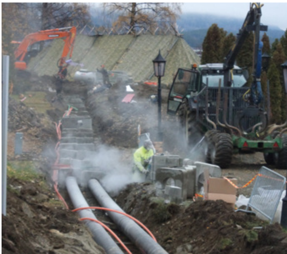
Sikring av rør mot oppflying med lodd i hagen til Fagernes Hotell, og tilpassing av lodd. Daglig leder Tor Oxhovd Svalesen er fornøyd med valget av serie III isolasjon på fjernvarmerørene. – Jeg er sikker på at det er det riktige for oss. Vi skal drifte dette nettet i 50 år og varmetap er en av våre største faste kostnader.
