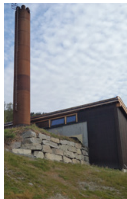
vi satt i gang byggingen av Stølslie Varmesentral i 2010, sier Tor Oxhøvd Svalesen. Varmesentralen måler 9 x 9,5 meter, har torv på taket og lav pipe, og leverer i dag 3,7 GWh varme, basert på skogsflis fra nærområdet.
