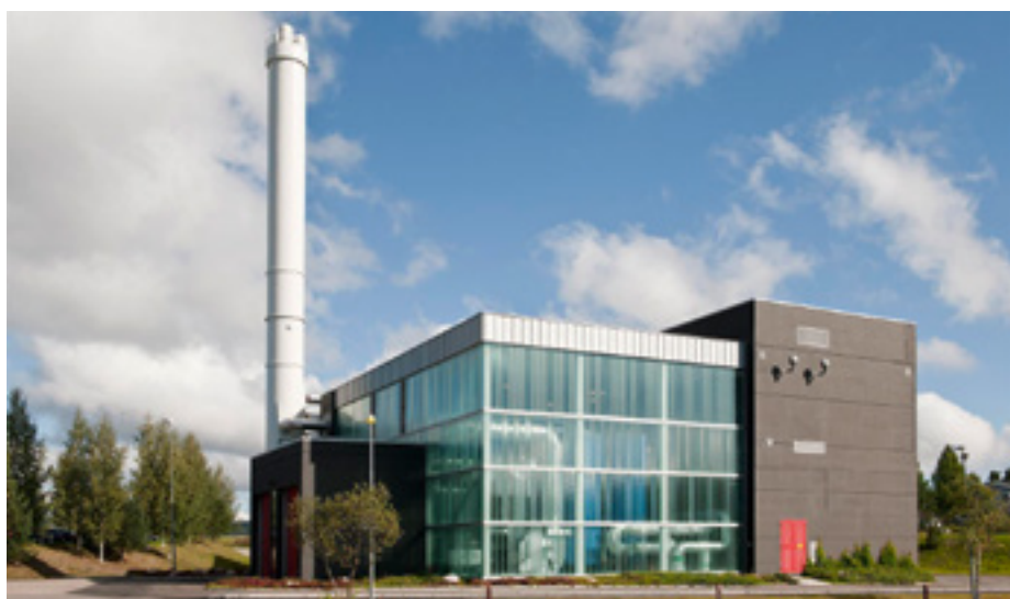
Robsrud Varmesentral er en arkitektonisk flott og teknisk kompakt varmesentral med en grunnflate på 1160 m2, med to fliskjeler hver på 4 MW, et røkgasskondenseringsanlegg på 2 MW, to oljekjeler på henholdsvis 4 og 8 MW, og i tillegg en liten elkjel. Ifølge Akershus Energi Varme vil produksjonen på Robsrud Varmesentral, som i fjor var på 37,5 GWh, nær dobles om ti år. Vel 90 prosent av brenselet er flis, fem prosent bioolje og fem prosent el, som også er 100 prosent fornybar fordi el er kjøpt med opprinnelsesgaranti. Med andre ord en meget miljøvennlig varmesentral.
