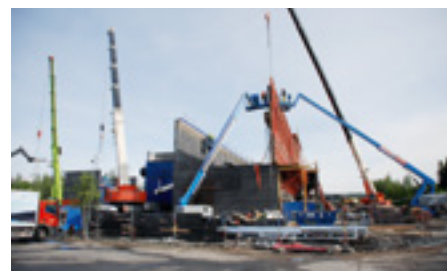
Byggingen av Robsrud Varmesentral gikk bra takket være god innsats fra involverte. Gravingen startet i september 2009, og allerede i julen 2010 kunne vi levere varme til vår første kunde, Posten, som avtalt, og i februar 2011 ble samtlige kjeler satt i drift.
