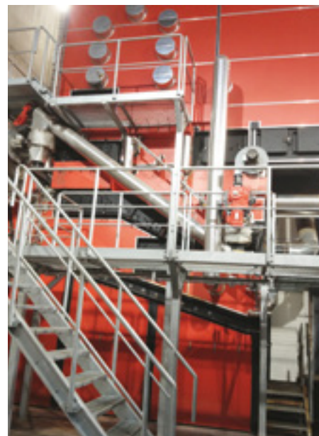
Det nye returflisanlegget i Hallingdal.
