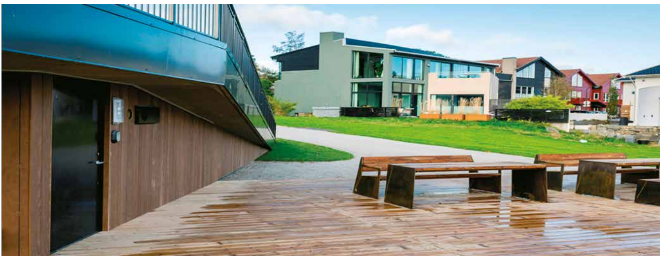
Overbygget på Forus Kjølesentral og deler av det opparbeidede utearealet. (Foto: Lyse Neo)
