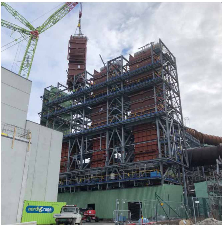
Overheterseksjonene ble heist på plass i april 2020.
