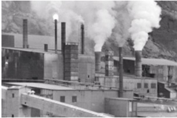
Bremanger smelteverk i 1979, den gang man begynte å betrakte det som et miljøproblem at røyken slapp rett ut. Kravet til avgassrensning banet vei for energigjenvinning. Foto: Hans Borchsenius.
