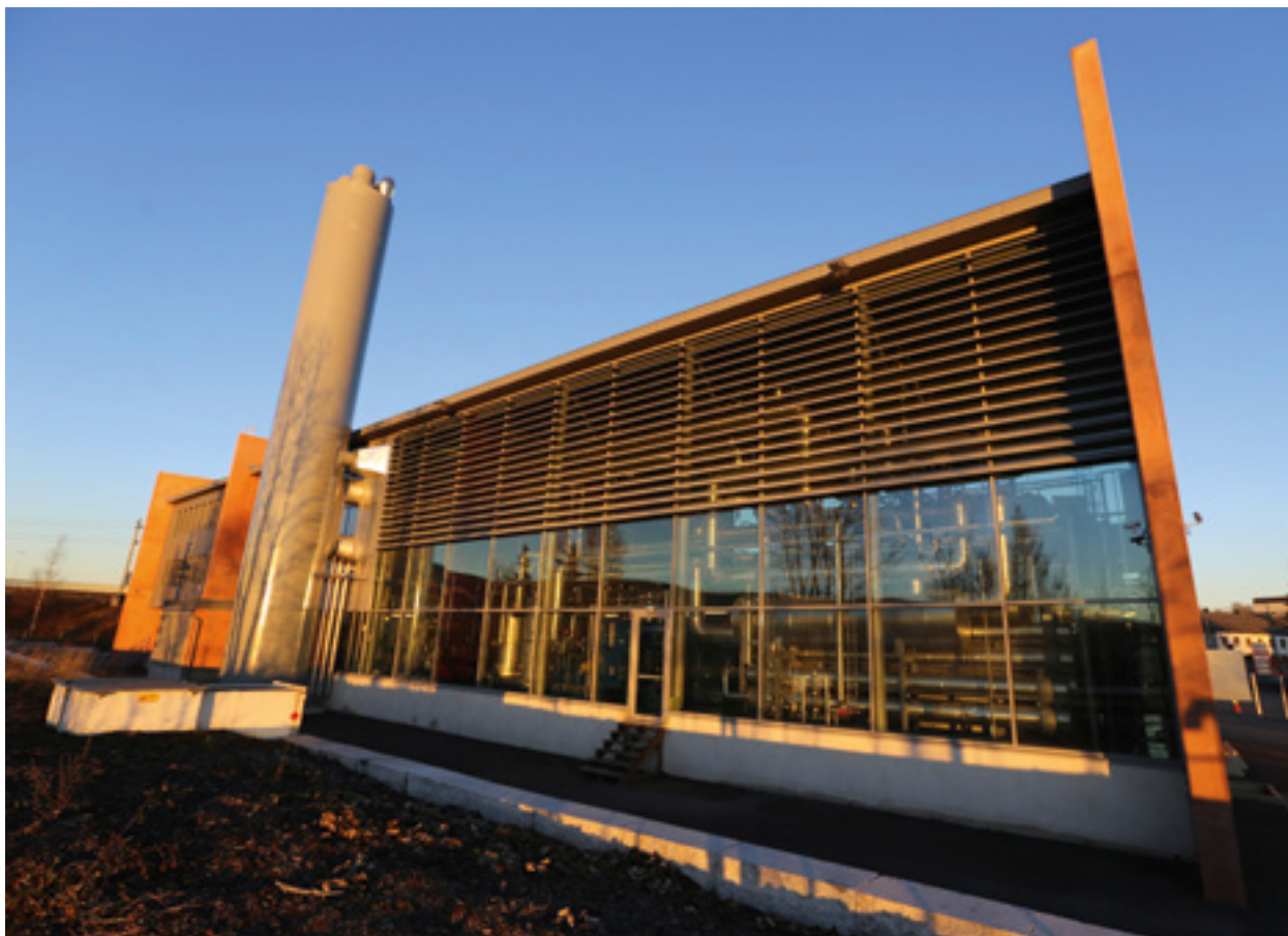
Den 13 MW store ammoniakkbaserte varmepumpen på Brakerøya Varmesentral i Drammen kan levere hele 90 °C utgående vanntemperatur.
