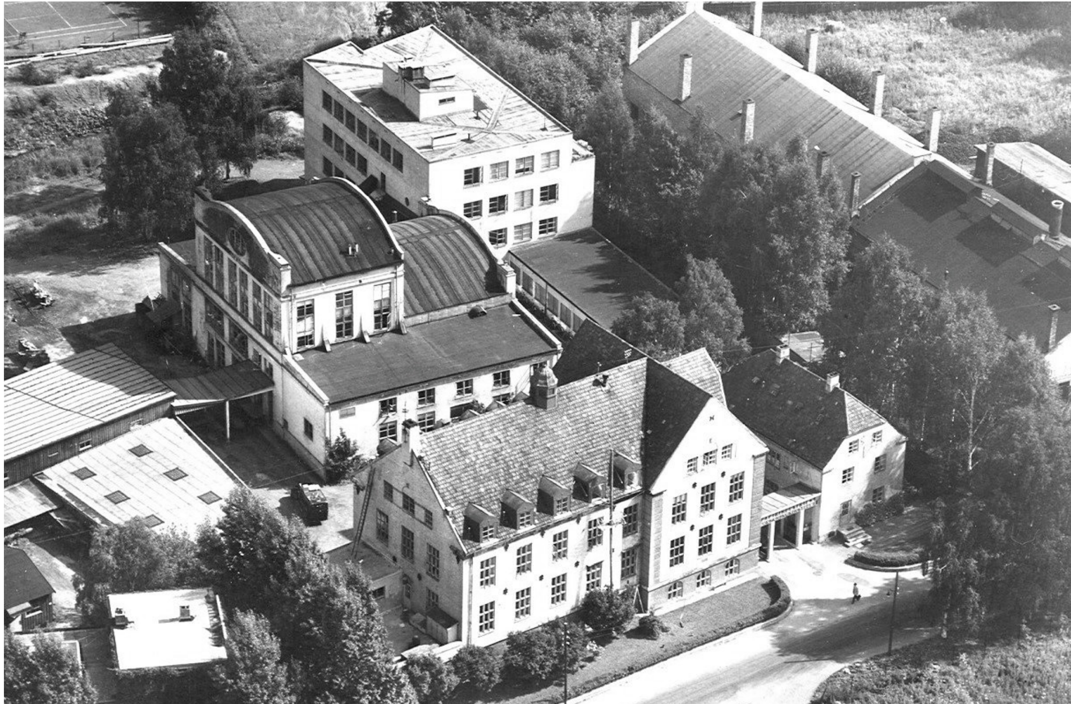
Hoffsveien 13 før påbygging mot nord.
