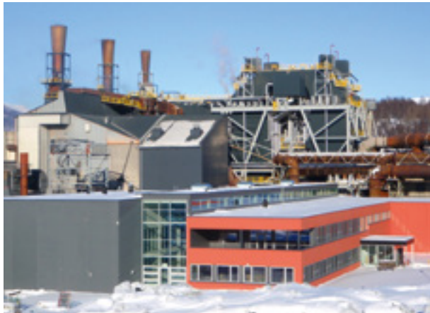
Mange ferrolegeringsverk har investert i energigjenvinningsanlegg. Bildet viser det siste store energigjenvinningsanlegget som ble satt i drift i 2012 på Finnjord AS.
