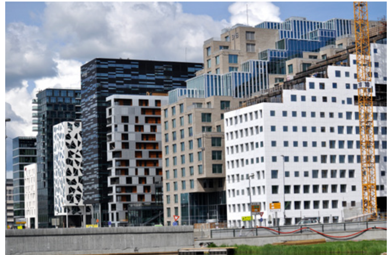
Assistanse til Barcode Kjøling for å forbedre anleggets ytelse.
