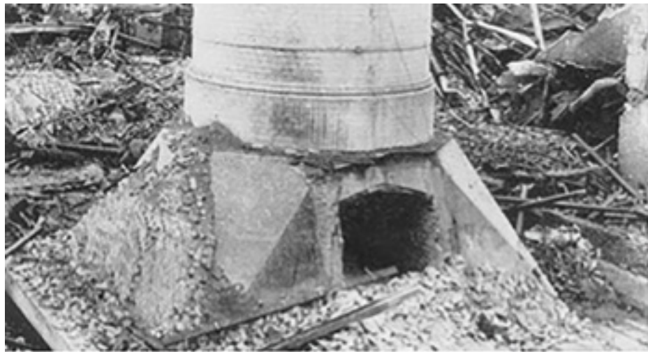
Dampeksplasjonen i en akkumulatortank på Greåker i 1958 raserte fabrikk og krevde menneskeliv.
