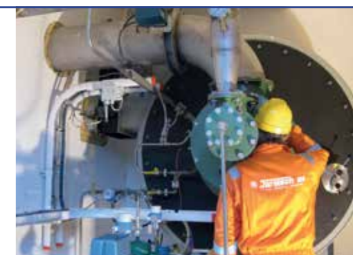
Glencore Nikkelverk, 7,6 Megawatt hauck lettoljebrenner, egedesignt brennkammer.
