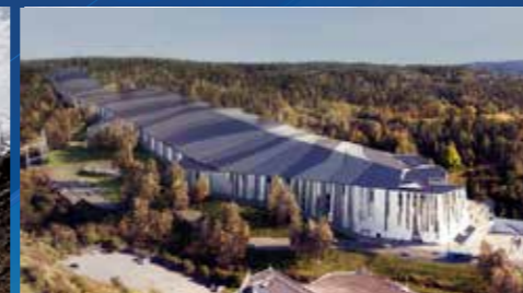
Energisentral og rørentreprise for kjøling og varmegjenvinning - SNO
