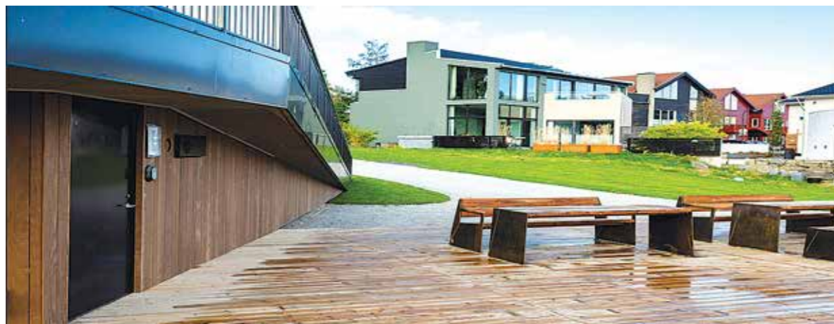
Overbygget på Forus Kjølesentral og deler av det opparbeidede utearealet. (Foto: Lyse Neo)
