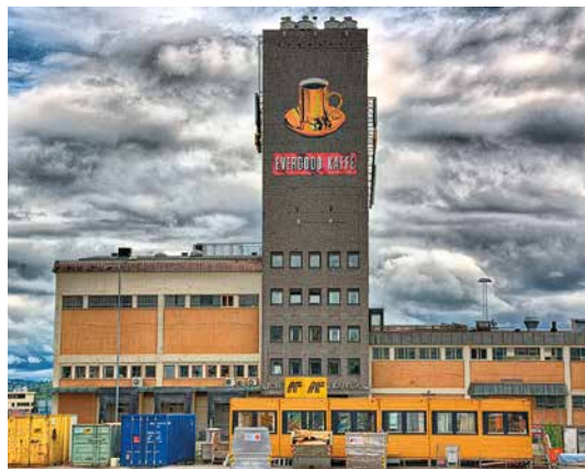
Joh. Johannson Kaffe AS produserer i dag kaffe på Filipstad i Oslo. Nytt kaffeforedlingsanlegg planlegges bygd i Vestby. Norsk Energi har en sentral rolle i prosjekteringen av det nye anlegget.
