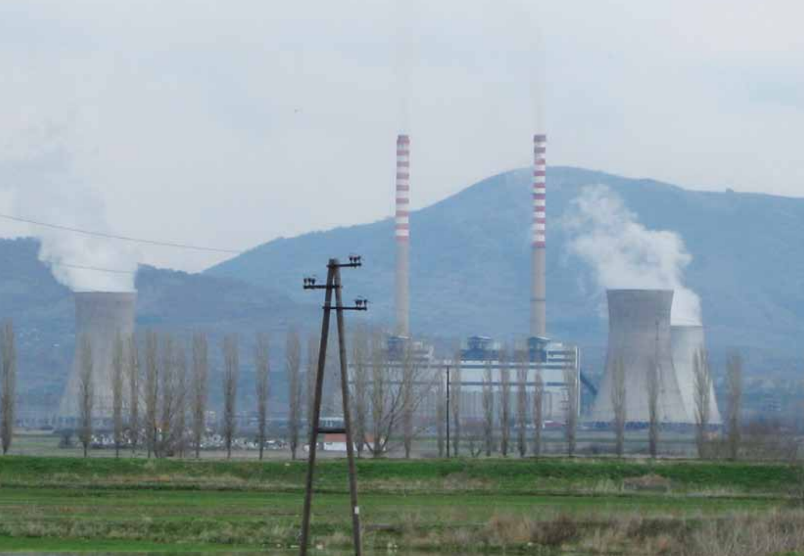
I første fase av samarbeidsprosjektet med miljøverndepartementet i Makedonia fokuserer vi på å assistere miljøverndepartementet i å utstede utslippstillatelser for industrisektorene energi og metallurgi. Bildet viser Makedonias største kullfyrt kraftverk.
