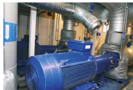
Fjernvarme sirkulasjonspumpe.
