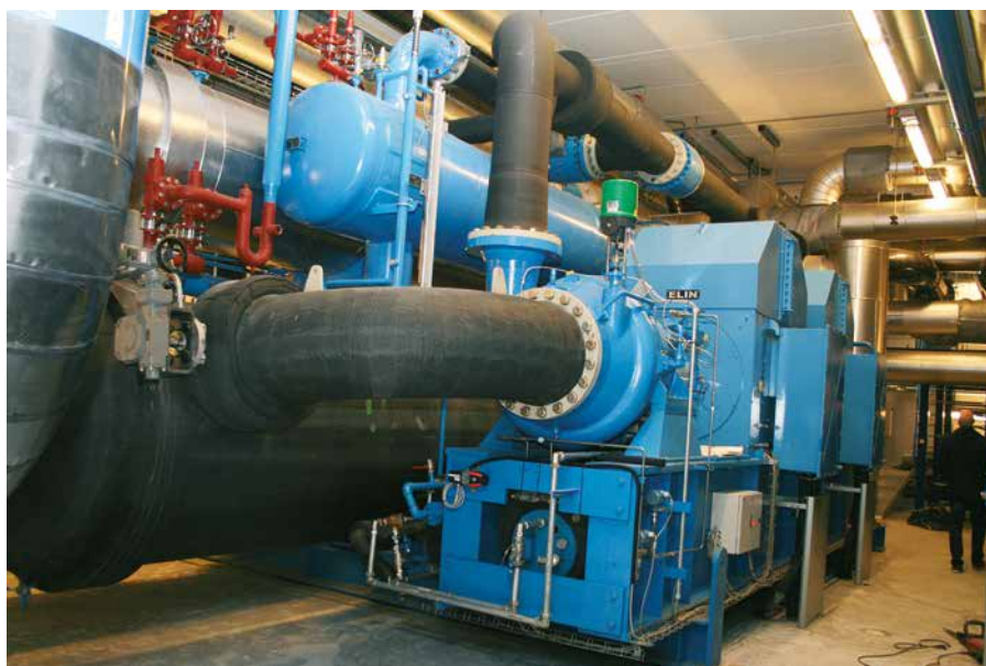
Friotherm varmepumper med varmemytelse lik 8 MW og kuldeytelse lik 10 MW.
