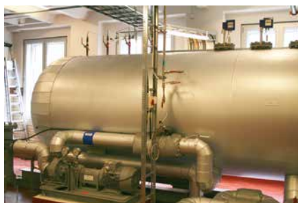
Kjelens ekspansjonstank.
