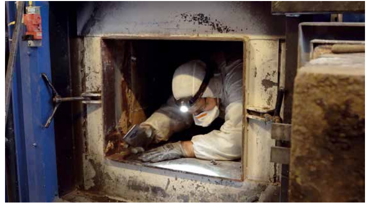
Inspeksjon på varmesentral. (Foto: Jan Almås)
