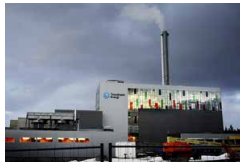
Et viktig prosjekt for Egil Evensen var bygging av Heimdal varmesentral linje 3 i Trondheim. Egil var prosjektleder fra starten 1999 til ferdig overtagelse i 2007.
