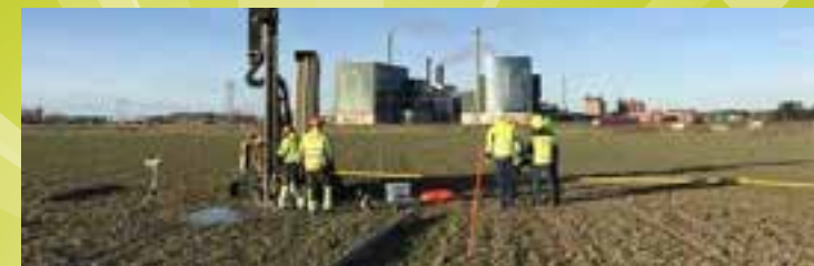
Prøveboringer og målinger for verdens største underjordiske høytemperaturlager i Linköping.
