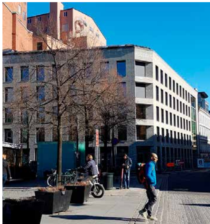
Youngstorget 3 i Oslo er Norges første næringsbygg med kjøling basert på fjernvarme.
