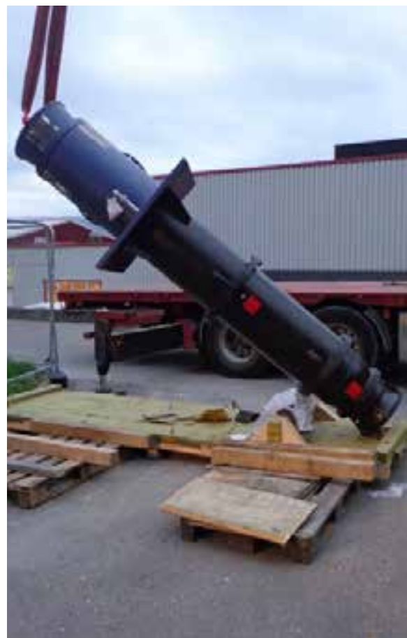
Ny kjølevannspumpe lastes inn.
