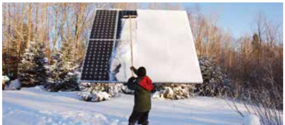
Selv langt mot nord kan faktisk solceller gi et betydelig energitilskudd. Litt upraktisk når det snør kanskje, men testforsøk viser at man får mer strøm fra solceller om vinteren enn tidligere antatt, blant annet på grunn av refleks fra snøen («påske-effekten»).
