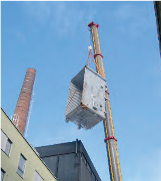
Den nye 100 MW store kjelen på Rodeløkka ble fraktet inn i tre deler som så ble satt sammen lokalt. Norges største mobilkran, med forlenget bom, ble nødvendig for å heise inn de store bitene fra gaten og over bygget.
