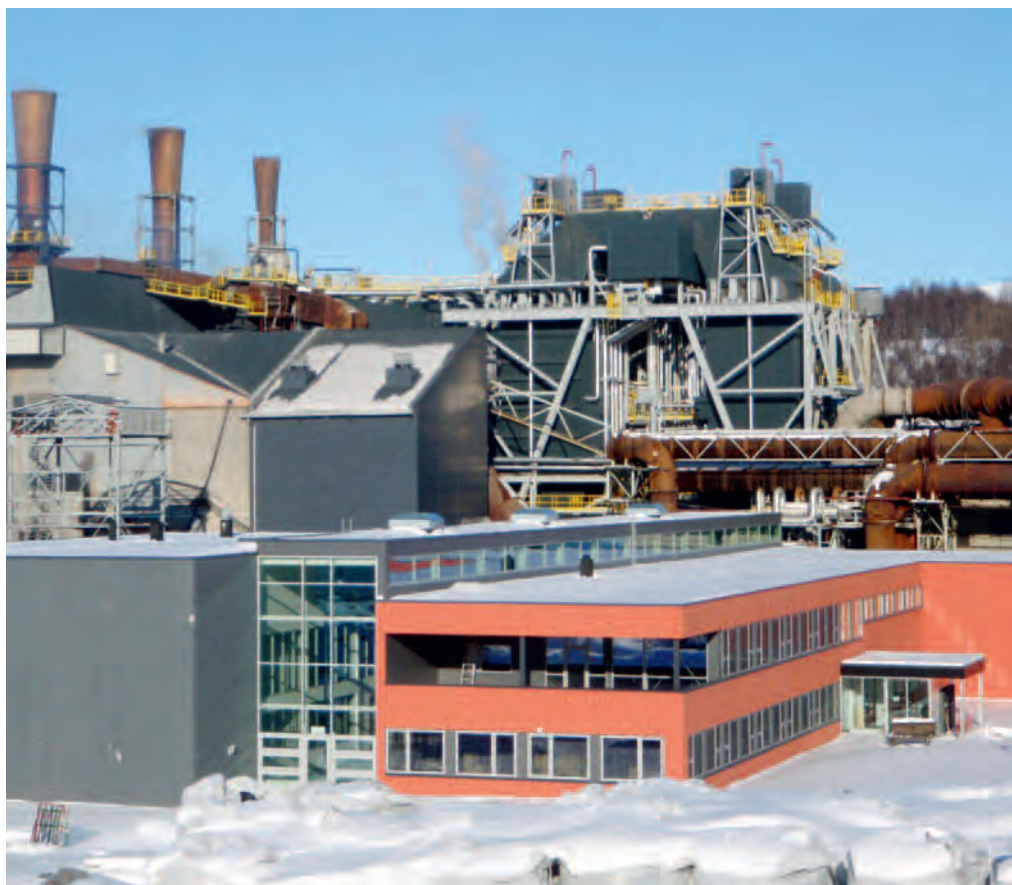
A Energigjennvinningsanlegget på Finnjord ble ferdigstilt i oktober 2012. Ovnshallen til venstre og varmegjennvinningskjelene til høyre. Foto: Georg Johannessen.
