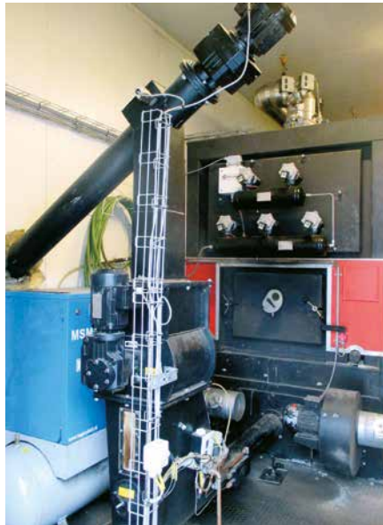
Innmattingsutrustning med stokerbeholder og stokerskrue.
