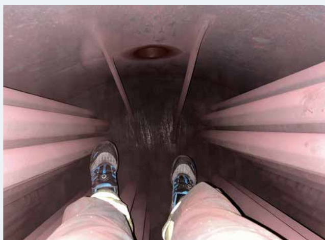
Inspektør i sving på vannsiden av en røykrørskjel.
