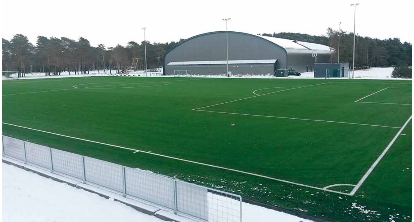
Farsund Kommunes miljøpark, som består av kunstgressbane, to fotballbaner, en håndballbane, to løpebaner, garderobe og kafé varmes opp med spillvarme fra avgassen i gassrens anlegget til elektrolyseprosessen ved Alcoa Lista.
