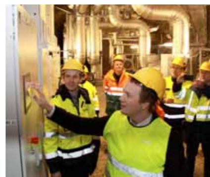
Bergens byråd for miljø og utvikling, Filip Rygg, trykker på startknappen for det nye boosterpumpelanlegget mens BKK varme sin ansvarlige for prosjektet, Gunnar Hernborg, spent følger med.
