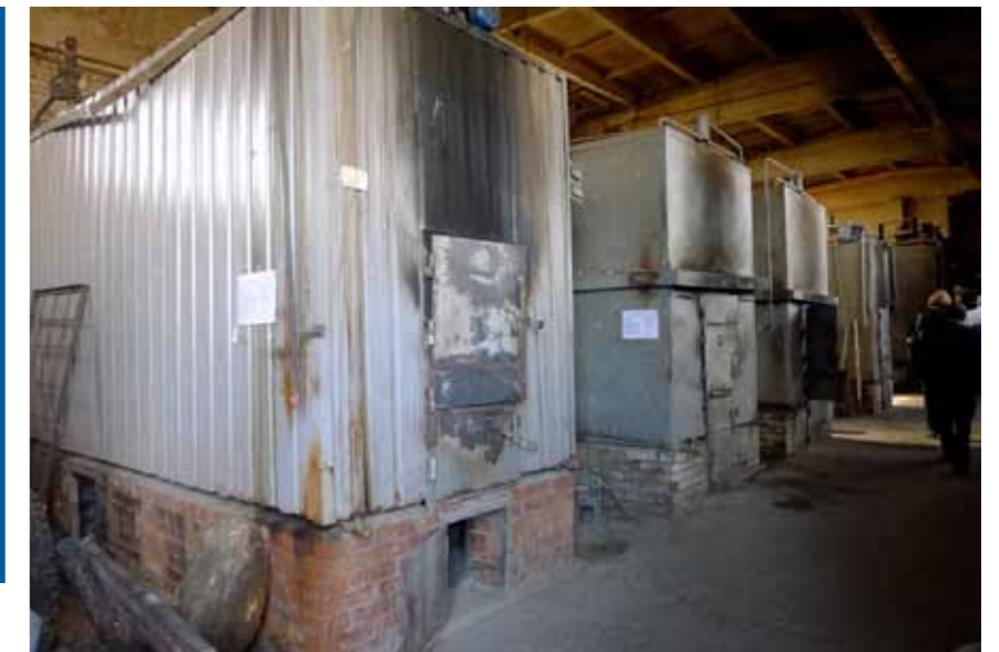
Russiskproduserte biobrensel-kjeler er billige, men tilfredsstillers ikke dagens krav verken til miljø eller virkningsgrad. Disse kjelene ble installert i 2008.
